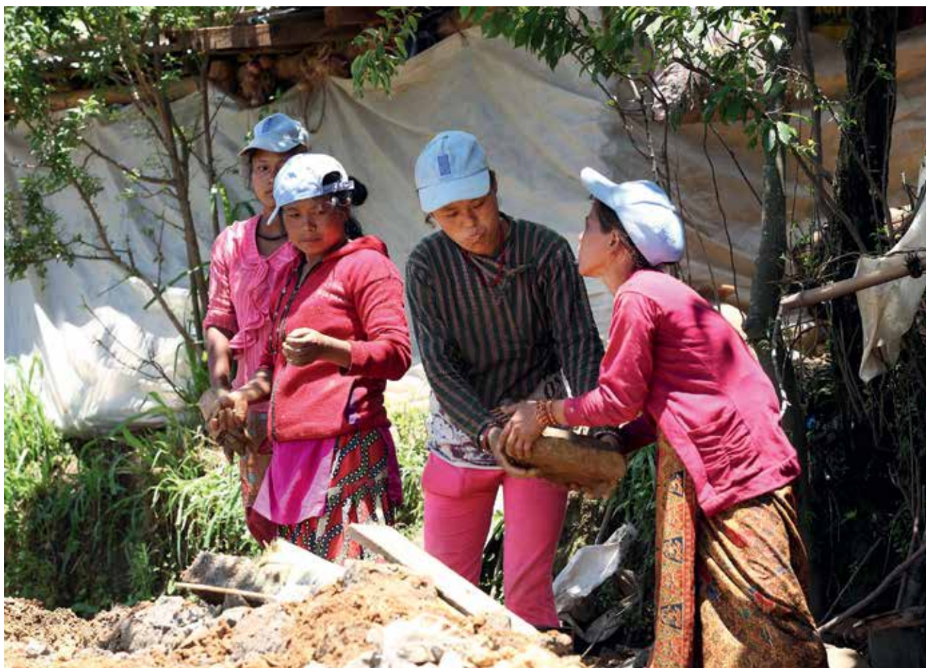
Местные добровольцы разбирают завалы после землетрясения в Непале в 2015 году (ДООН, 2015 год).
