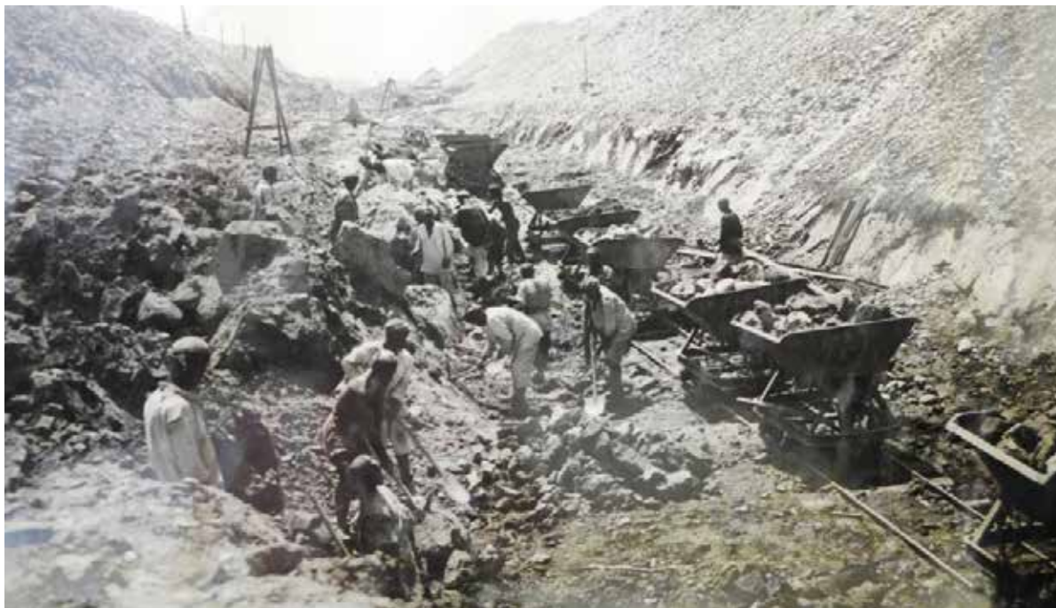
В строительстве Вахшского магистрального канала участвовали добровольцы, прибывшие со всей территории СССР. Фотография 1933 года.
